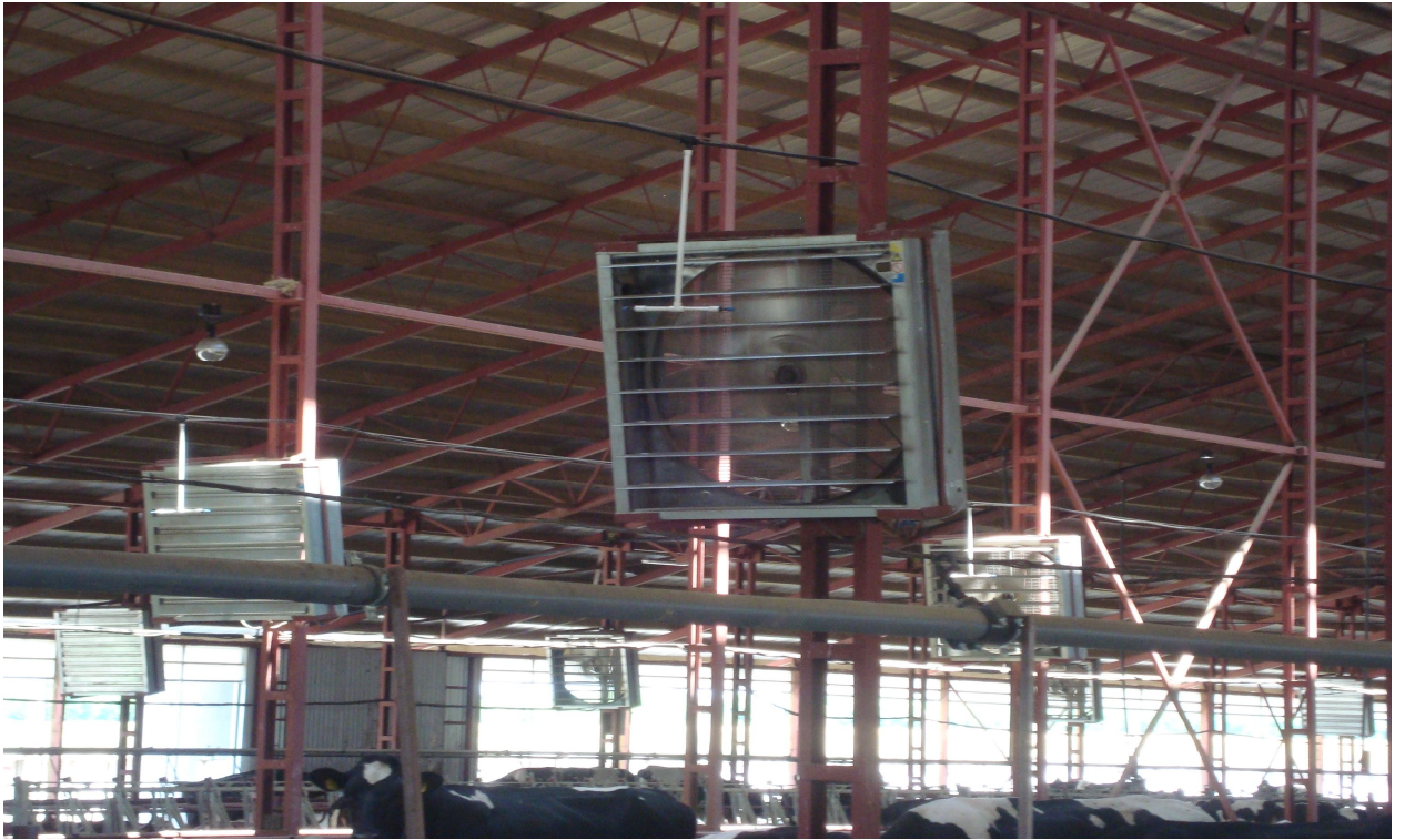
Рис. 6. Система регулювання температури повітря у корівнику за допомогою вентилятора і пристрою водного зрошення
