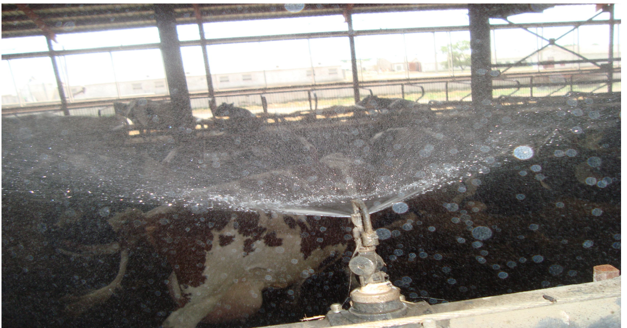
Рис. 7. Пристрій водяного зрошення, який розміщено над кормовим столом
