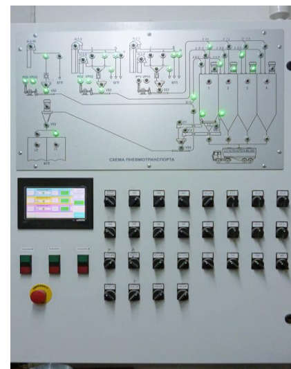
Рис. 5. Щити автоматизацію технологічної лінії транспортування та очищення зерна кукурудзи
