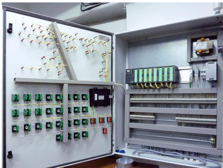
Рис. 5. Щити автоматизацію технологічної лінії транспортування та очищення зерна кукурудзи
