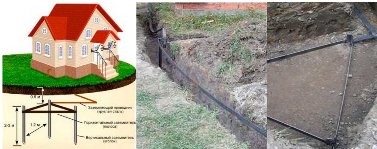
Рисунок № 1. Виконання заземлюючого контуру для електричного обладнання замської садиби
