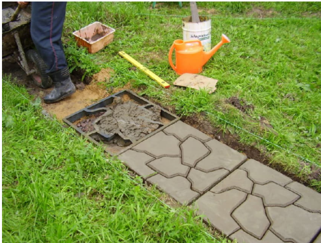
Рис. 13. Виготовлення доріжок за допомогою трафарету
