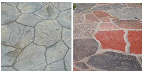
Рис. 9. Декоративний бетон. Існує три базові технології виготовлення садових доріжок з бетону: штампований, трафаретний і напилений бетон.
