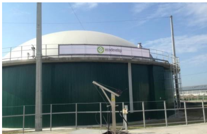
Рис. 11. Загальний вигляд газгольдера
