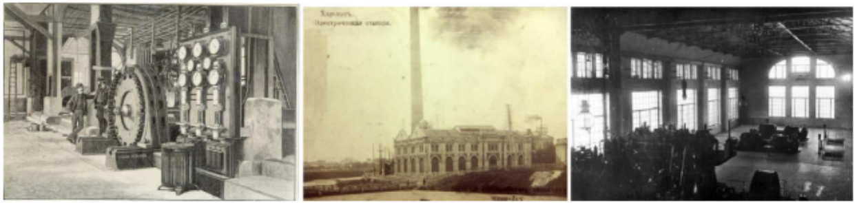
Рис. 1.6 – Зовнішній вигляд перших електростанцій з асинхронними електроприводами
