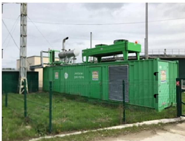
Рис. 12. Когенераційна установка енергогенерування на базі БГУ в умовах СПрАТ «Україна»
