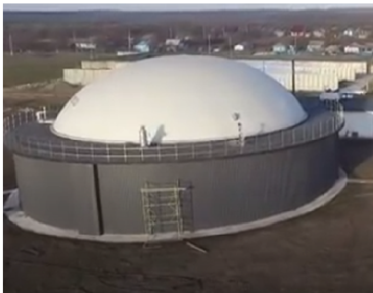
Рис. 10. Ферментер для виробництва біогазу в умовах СПрАТ «Україна»
