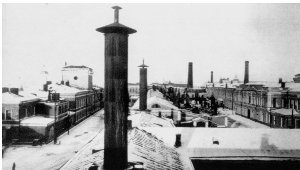
Збрійний завод, м. Тула
