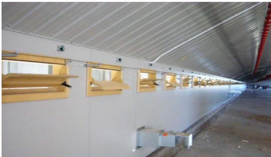
Рис. 9. Установка вентиляції штучного збудження повітря – припливна калориферна
