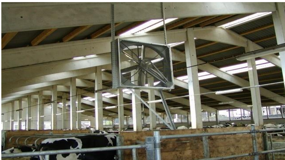
Рис. 2. Вентилятори для охолодження температури повітря у корівнику
